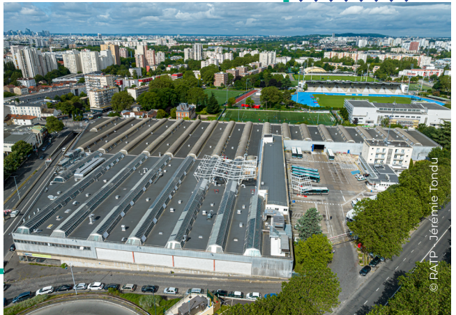
Centre opérationnel bus de Saint-Denis - Panneaux photovoltaïques en toiture
