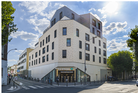
RATP Habitat - réalisation de 19 logements sociaux au-dessus de la station La Dhuis (L11)
