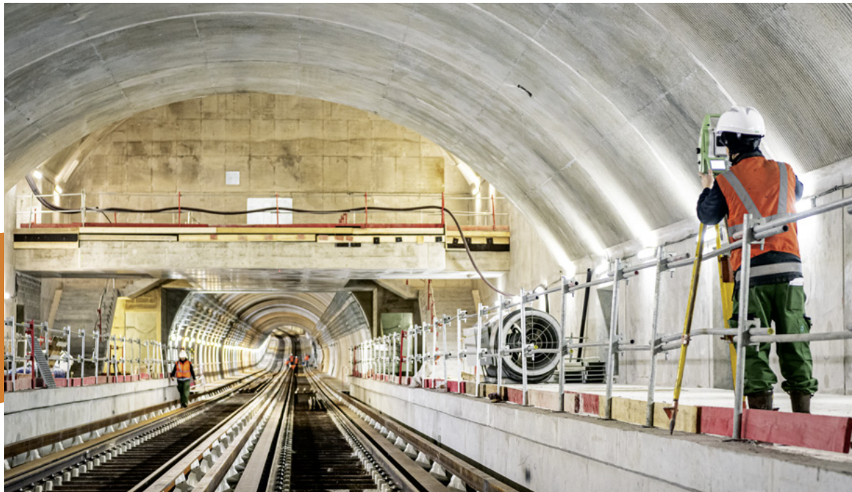
Chantier de prolongement de la ligne 4.
