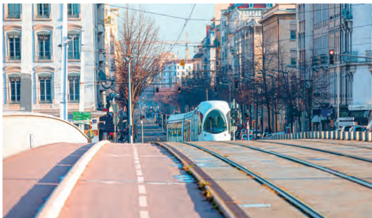
↑ Ligne de tramway dans la ville de Lyon.
